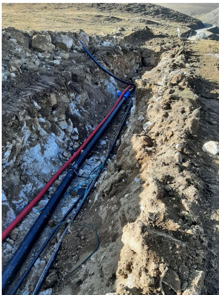
Trincea di scavo con in evidenza condotte da 100 mm di diametro e sottoservizi di linea
